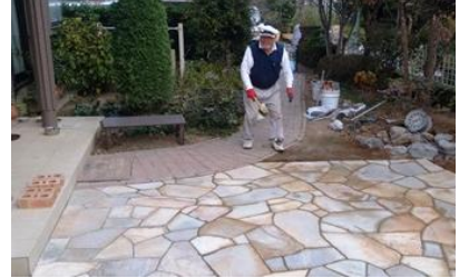
個人邸石貼り工事
