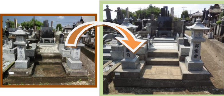
敷き砂利を取り除き御影石を貼り、お手入れしやすくなりました。お墓全体のクリーニングを行い、文字の色を入れ直し、一段と明るい雰囲気になりました。
